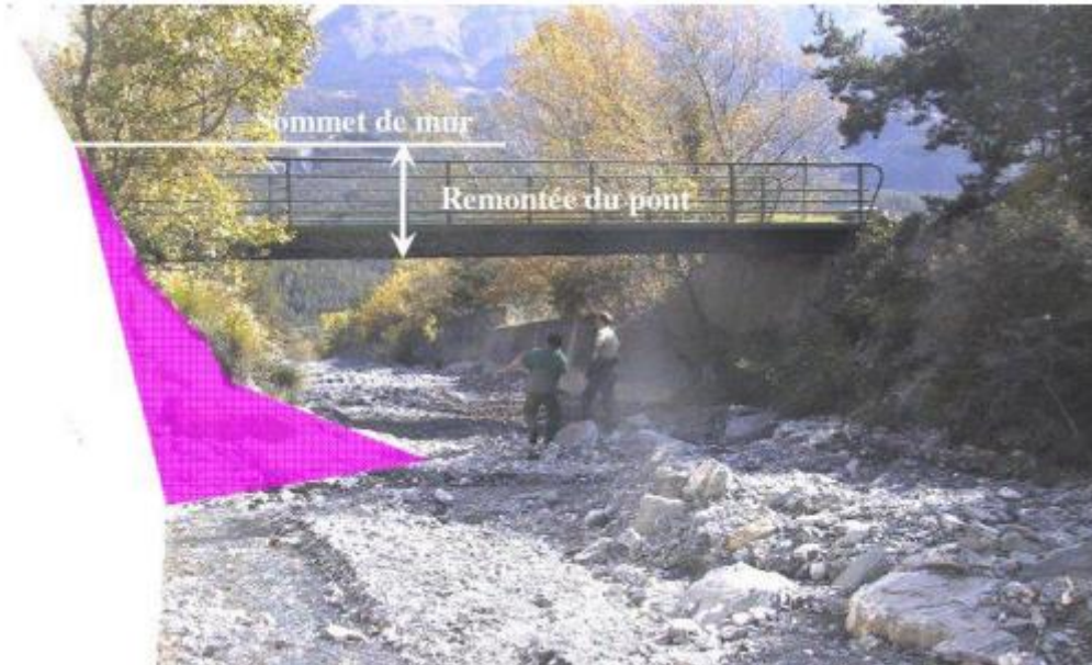
Figure 4 : Aménagement du pont de Briançon (vue depuis l'amont)
