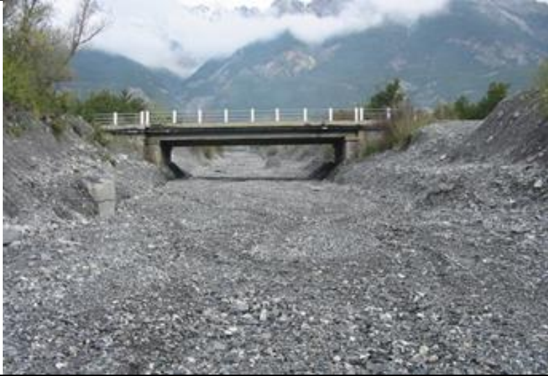
TB1 – ouvrage enseveli - 2006
