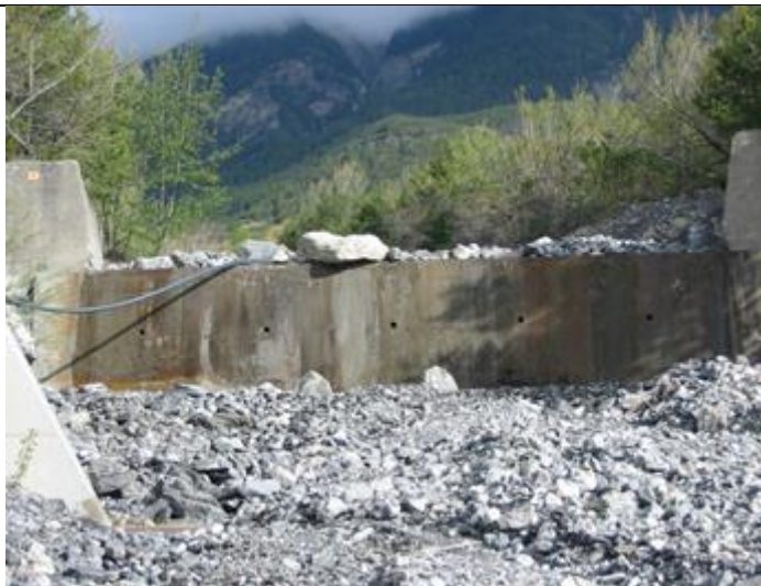
TB2 – ouvrage enseveli -2006
