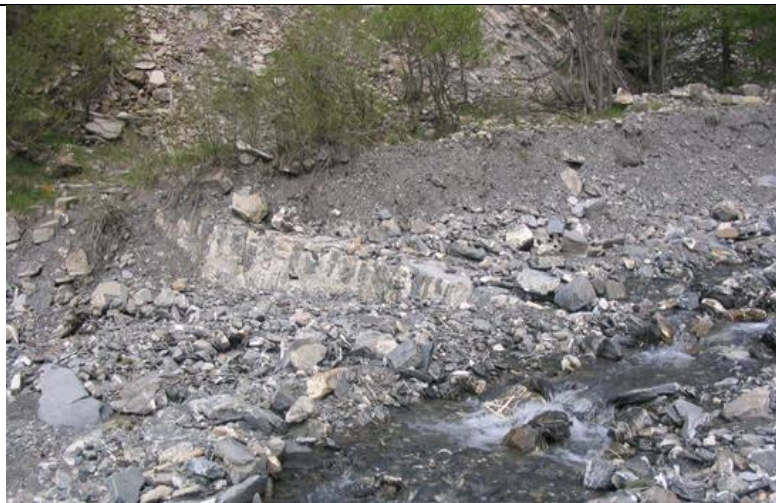
B49 (ouvrage non retrouvé en 2015, photo de 2006)
