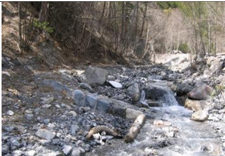
B5 – ancien ouvrage pratiquement totalement enfoui en 2015 (photo de 2006)
