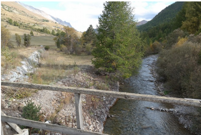
Illustration 5: Vue de la levée du camping des Marmottes de puis la passerelle piétonne
