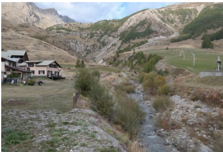
Illustration 1: Vue amont du torrent de Rouchouse depuis le pont de RD 900
