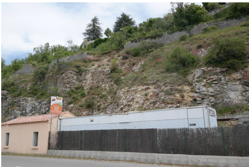
Illustration 1: Escarpement rocheux surplombant le restaurant de la RD 950
