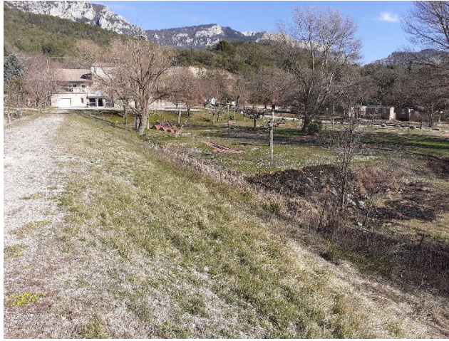
Photo 4 : parement aval rive gauche
