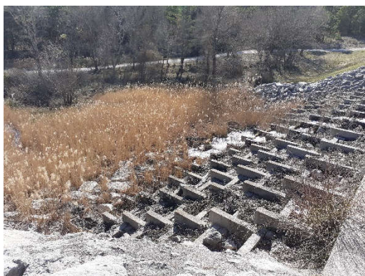
Photo 3 : coursier de l'évacuateur de crues
