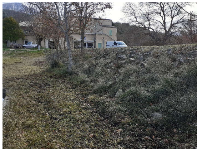
Photo 5 : parement amont rive gauche
