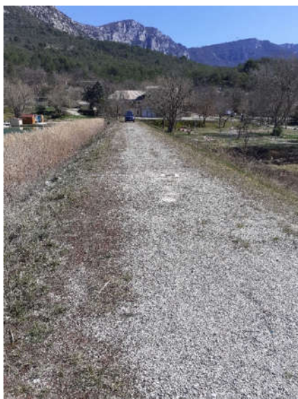
Photo 2 : crête du barrage
