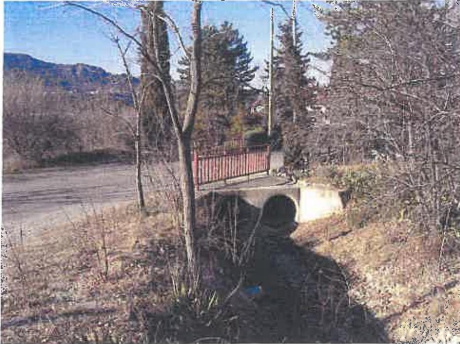
Sur une centaine de mètres, le torrent emprunte ensuite un lit de section très nettement insuffisante, et par ailleurs encombré par la végétation (cf. photo 9). Des débordements marqués peuvent s'y produire, ainsi qu'au niveau du pont de la route de SAINT-ANDRÉ (ouvrage béton d'une section rectangulaire de capacité 5 m<sup>3</sup>/s).
