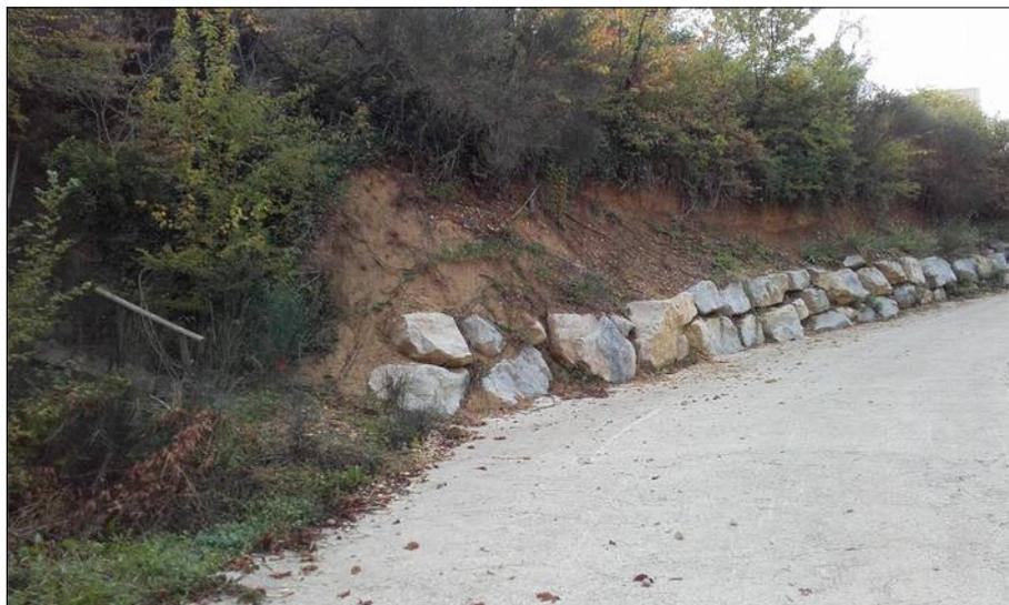
Figure 15: Talus instable terrassé dans des terrains argileux avec un soutènement d'enrochements.
