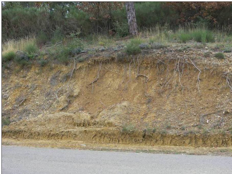
*Figure 14: Glissement superficiel affectant un talus routier constitué de terrains argileux.*
