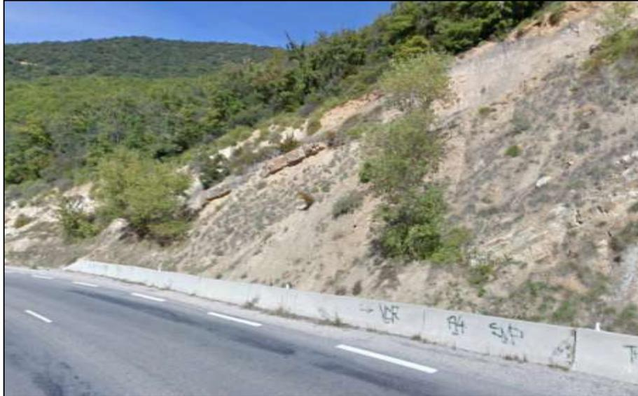
**Figure 75 :** Pare-blocs en pied d’affleurement le long de la RD 13, dans le secteur du Bois d’Asson [Source : Street View]
