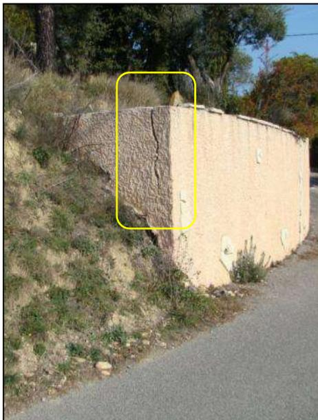
Dans les zones les plus actives, les instabilités potentielles peuvent se traduire par l'**endommagement des constructions et infrastructures** (fissuration) du fait de la déformation de leurs fondations ou de leurs soubassements (à cause des efforts en traction).
