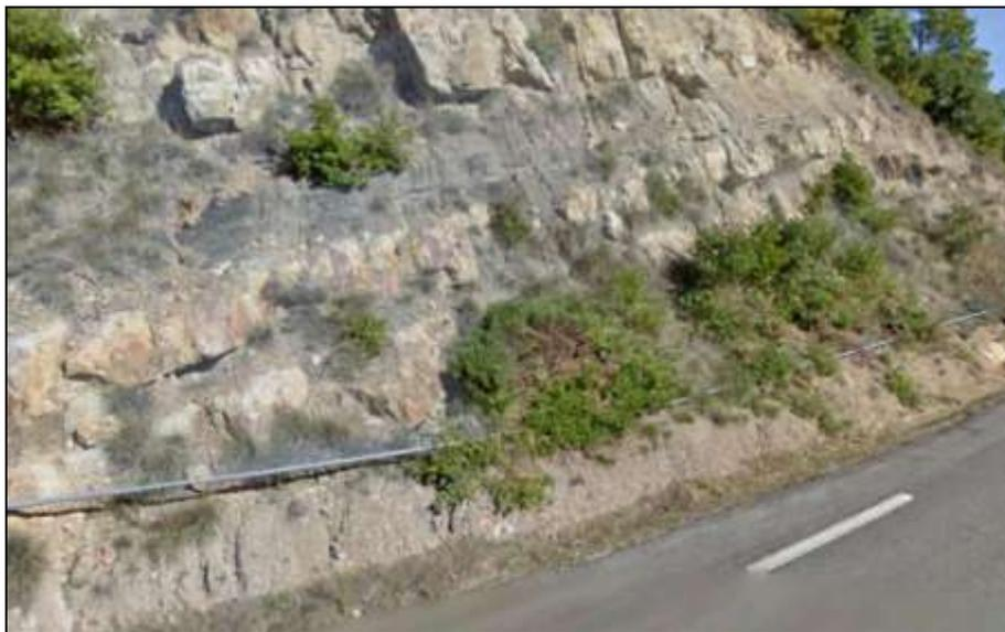
**Figure 76 :** Grillages pare-pierres posés contre un talus rocheux le long de la RD 13, dans le secteur du Bois d’Asson [Source : Street View]
