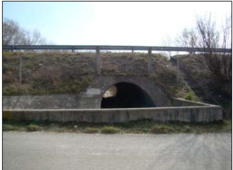
Figure 47 : Buse traversant l'A 51 en amont de la station d'épuration [Source : IMS<sub>RN</sub>]
