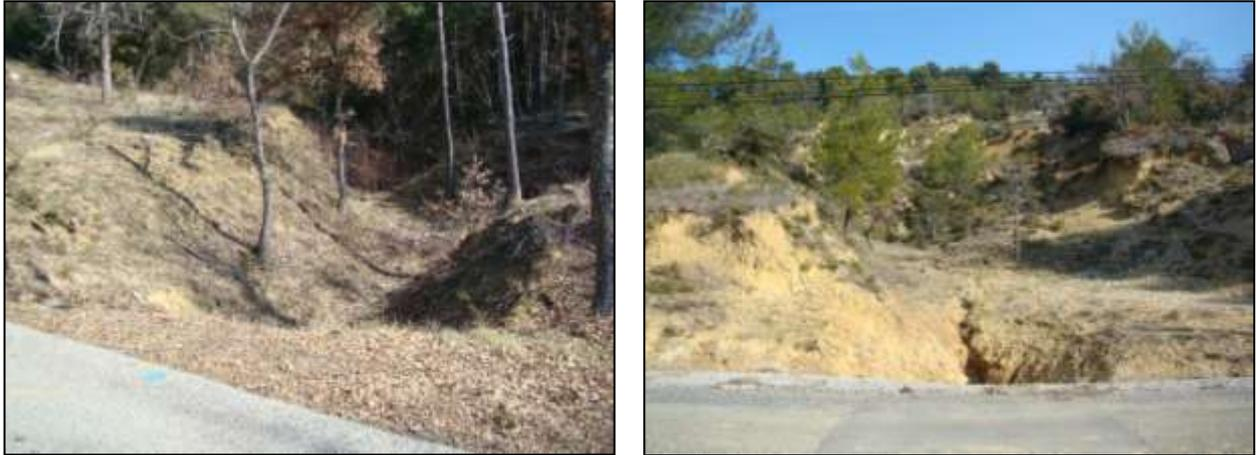
**Figure 56** : Ravine (à gauche) et talweg partiellement érodée (à droite) le long de la RD 216, dans le secteur de la Colle [Source : IMS<sub>RN</sub>]
