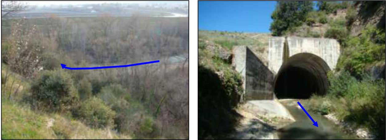
**Figure 32 :** Le Largue passant sous le remblai du canal EDF [Source : [IMS<sub>RN</sub>](#)]
