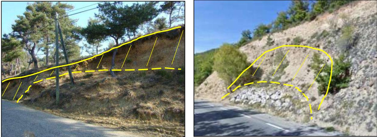
**Figure 79** : Loupes de glissements le long de la RD 216, dans le secteur de la Colle (à gauche) [Source : IMS<sub>RN</sub>] et avec enrochement le long de la RD 13, dans le secteur du Bois d'Asson (à droite) [Source : Street View]
