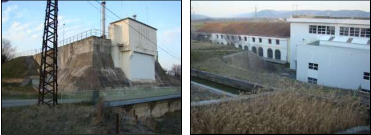
**Figure 39** : Centrale de la Brillanne avec l'arrivée du canal dans les conduites forcées (à gauche) et l'usine abritant les turbines et les générateurs (à droite) [Source : IMS<sub>RN</sub>]
