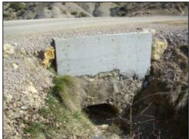
**Figure 59 :** Buses sous-dimensionnées et/ou obstruées le long de la RD 216, entre Font Chabanne et Tourrache [Source : IMS<sub>RN</sub>]
