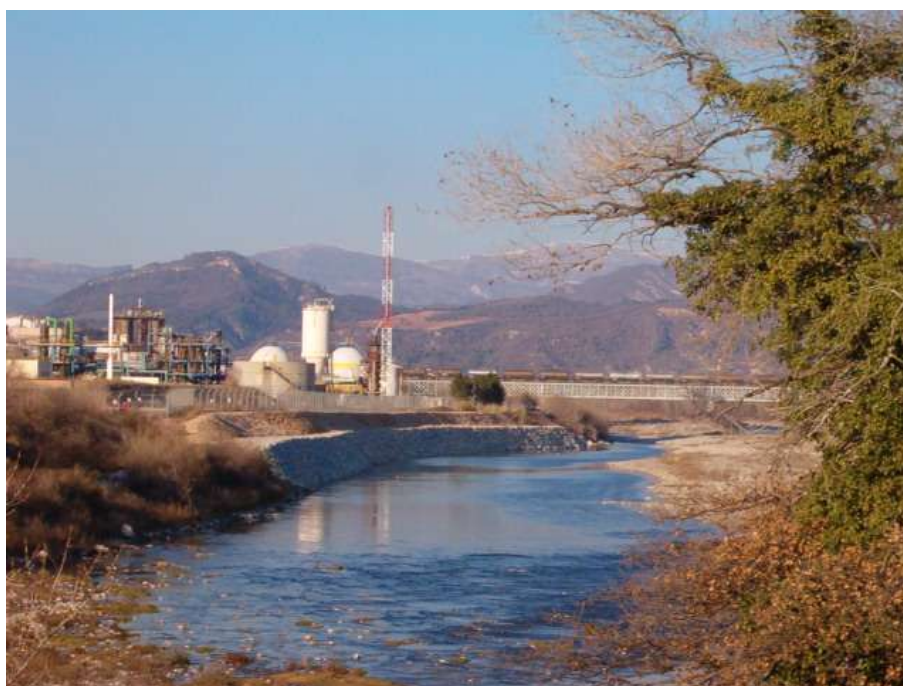
Figure 1: Les enrochements mis en place en rive droite e la Durance au droit de la plate-forme chimique à la suite de la crue de 2003.
