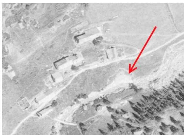
Illustration 8: Glissement de berge visible sur la photographie aérienne de 1971 à l'aval de la construction de la parcelle G-479
