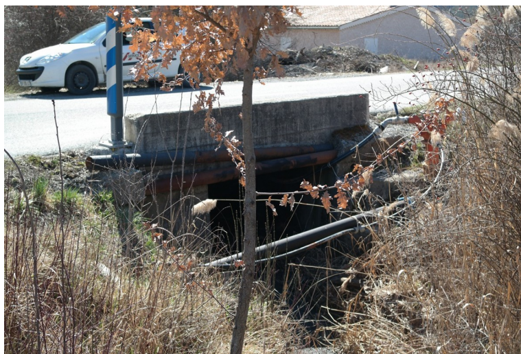
Illustration 1: Ouvrage de franchissement de la RD951 de la combe de Gaillard
